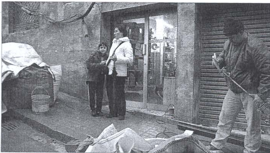
Treballs al barri del Carmel un any després de l'esfondrament que va obligar a desallotjar veïns ■ JORDI GARCIA / ARXIU
