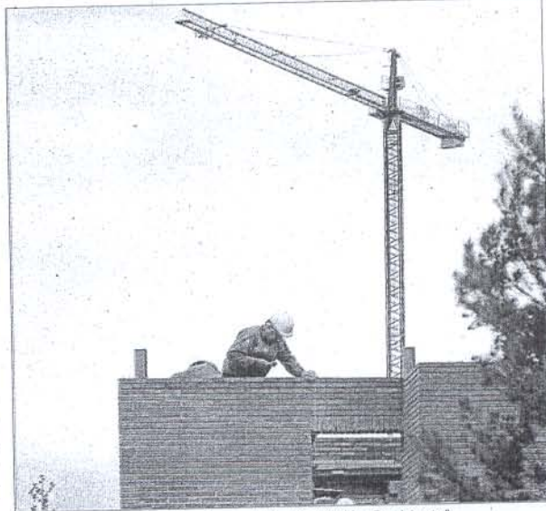
► Construcción de viviendas en Mira-Sol (Vallès Occidental).
