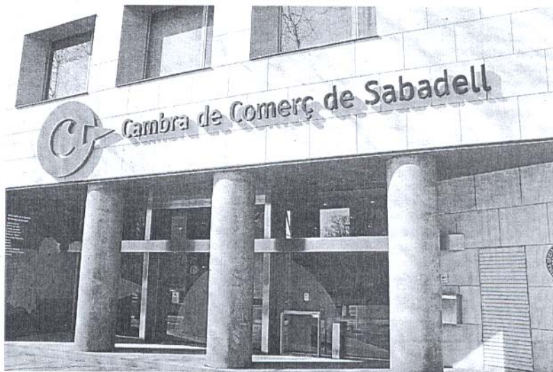
Sede central de la Cámara de Comercio de Sabadell
