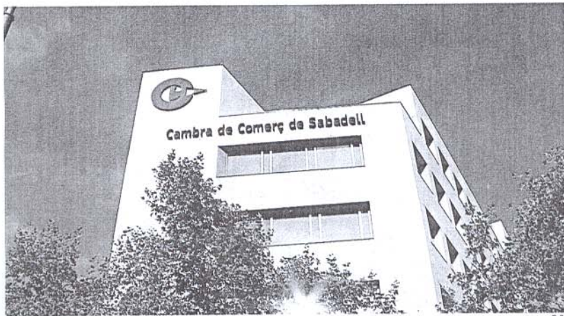
Sede central de la Cámara de Comercio de Sabadell
