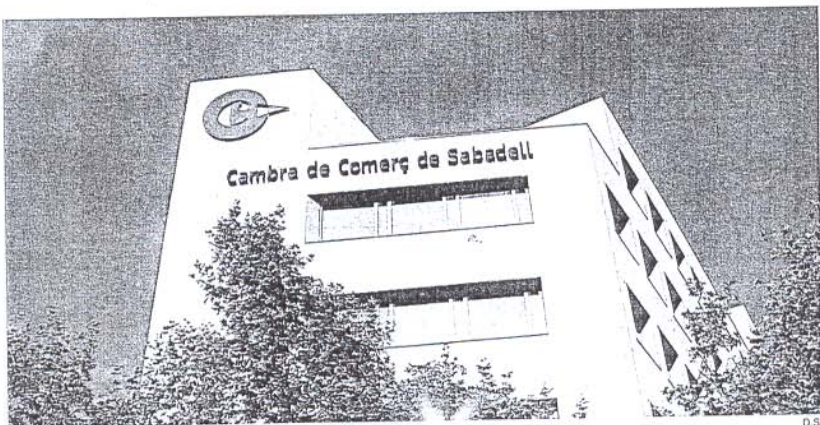
Sede central de la Cámara de Comercio de Sabadell en el Eix Macià
