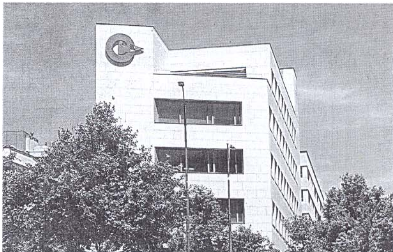
Sede central de la Cámara de Comercio de Sabadell
